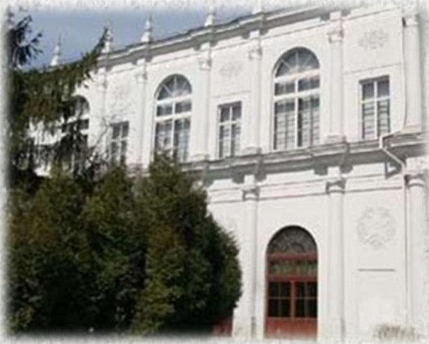
Тильна сторона приміщення на вул. Пекарській, 50 (станом на 2013 р.)
