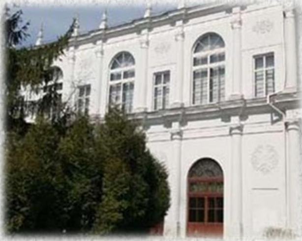
Тильна сторона приміщення на вул. Пекарській, 50 (станом на 2013 р.)
